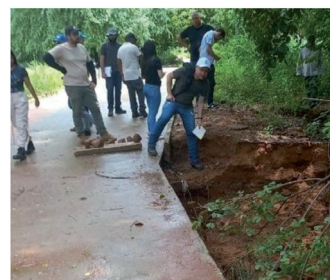
c) Descalçamento severo de passeio
